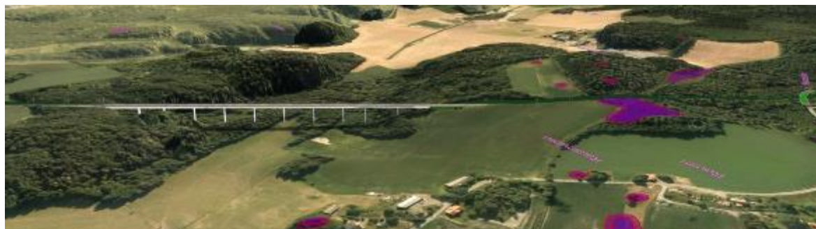
Figur 2-7 Dobbeltsporet krysser sør i landskapsrommet ved Rauan. Sett fra nord, retning Larvik mot høyre.
