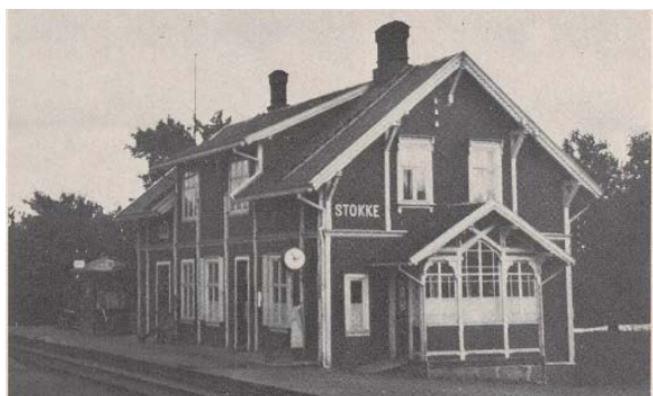
Figur 5-3 Stokke stasjon 1924 etter ombygging. Kilde: Bane NOR.
