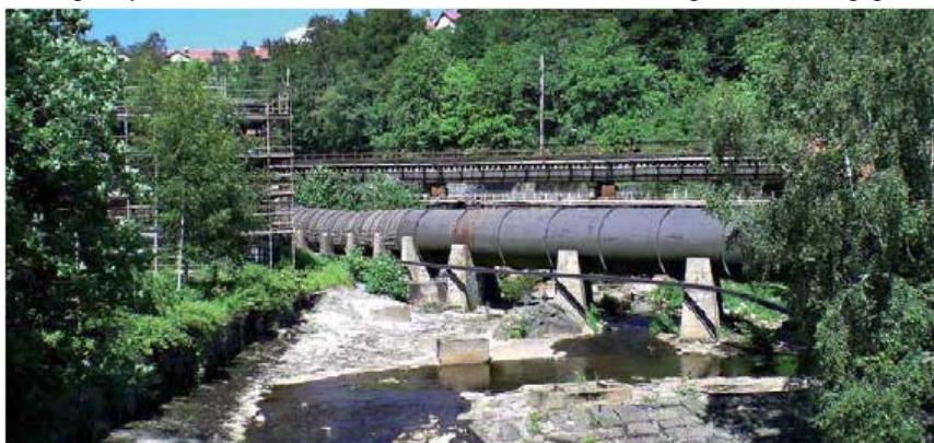
Figur 7-12 Rørgate 2 og jernbanespor over Farriselva. Kilde: NIKU Rapport28, 2007.
