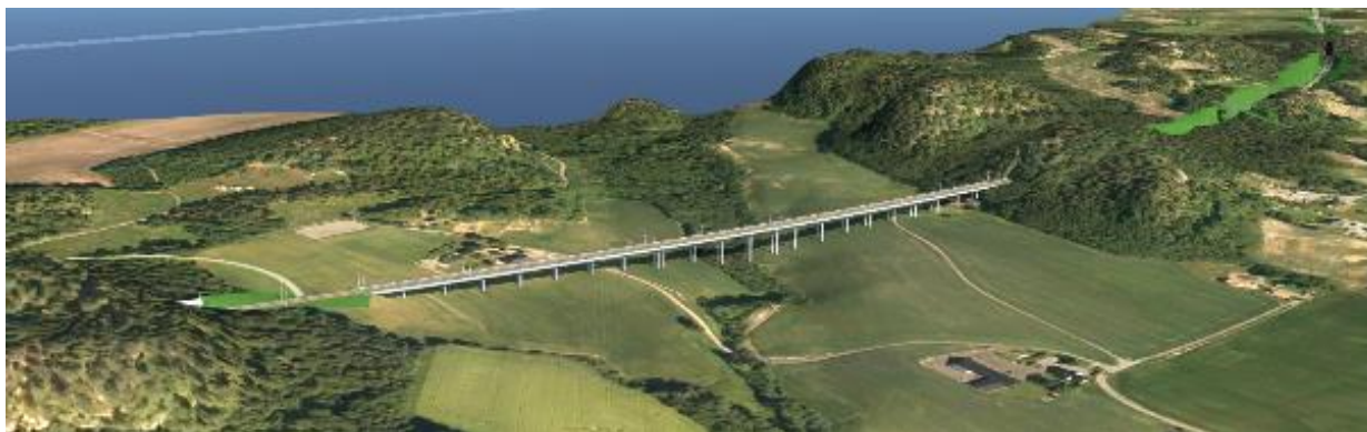
Figur 2-2 Trasé i Torp vest-korridoren med åpen skjæring gjennom Stangeskogen og lang bru over Unnebergdalen. Sett fra sørøst, retning Sandefjord er mot venstre.
