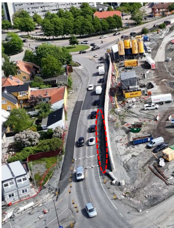
Figur 1. Det må asfalteres langs sørlig del av støyskjermen ved Fjordveien.
